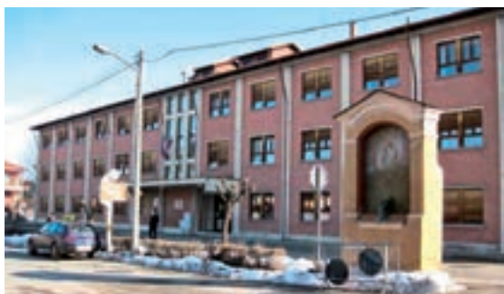
SCUOLA ELEMENTARE A. SOBRERO. Individuata tra gli edifici bisognosi di un intervento di efficientamento energetico
