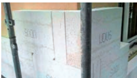
SCUOLA MEDIA L.EINAUDI. Posa del cappotto sul perimetro esterno dell'edificio
