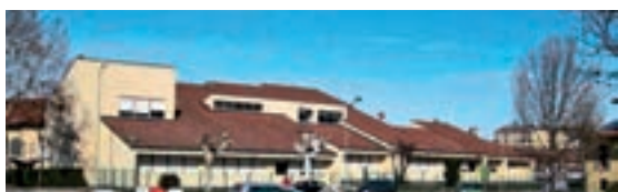
SCUOLA MEDIA L. EINAUDI. Oggetto del primo intervento di riqualificazione al termine di un'accurata diagnosi energetica
